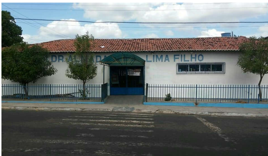
Fig. 2 – Fachada da escola Unidade Integrada Dr. Almada Lima Filho
